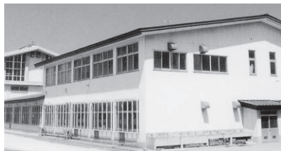
食品科学実習棟（昭和63年度完成）
