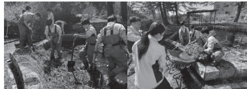
図7 噴水内の泥の撤去作業
