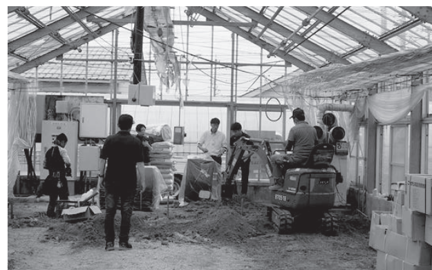
図7 温室の改修工事
