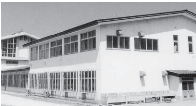
食品科学実習棟（昭和63年度完成）
