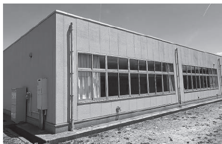
3号館 福祉実習棟（平成17年3月完成）
