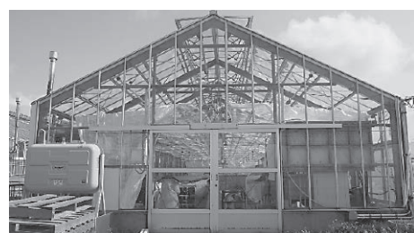
図3 翠星高等学校 ガラス温室
