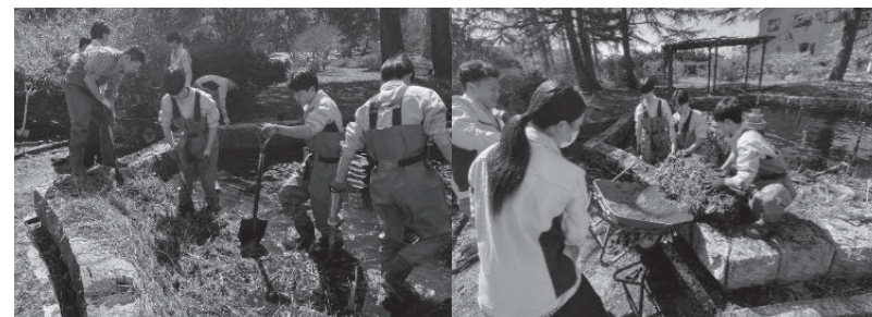
図7 噴水内の泥の撤去作業
