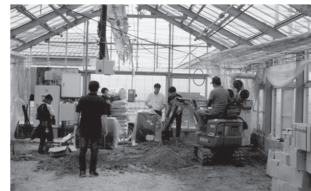
図7 温室の改修工事
